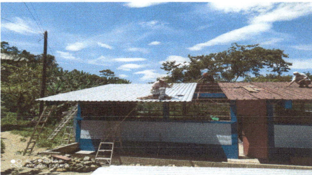
Foto 3: Sustitución de lamina modulo 1
