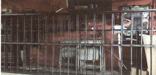
Foto1: Realización de balcones
